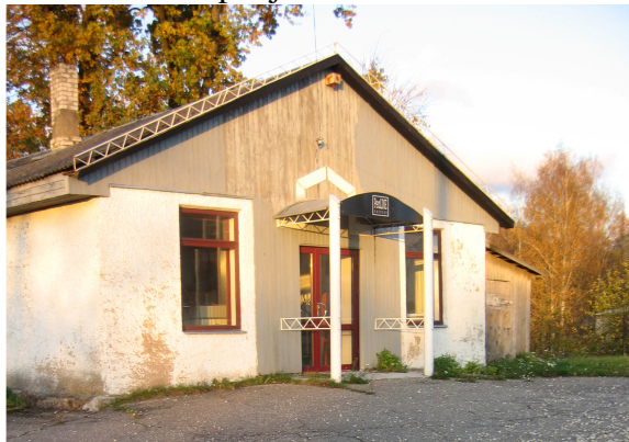
Foto 4. Vaade põhja-kaares hoonele
